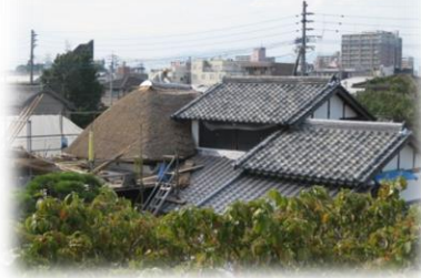
▲葦葺き屋根の葺き替え
