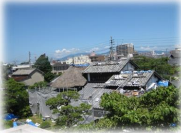
▲瓦屋根の葺き替え
